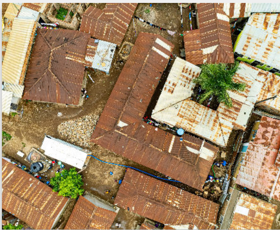
Un bidonville typique, où la pompe PuPu a été placée pour vider une fosse et pomper les boues dans un camion à proximité.
